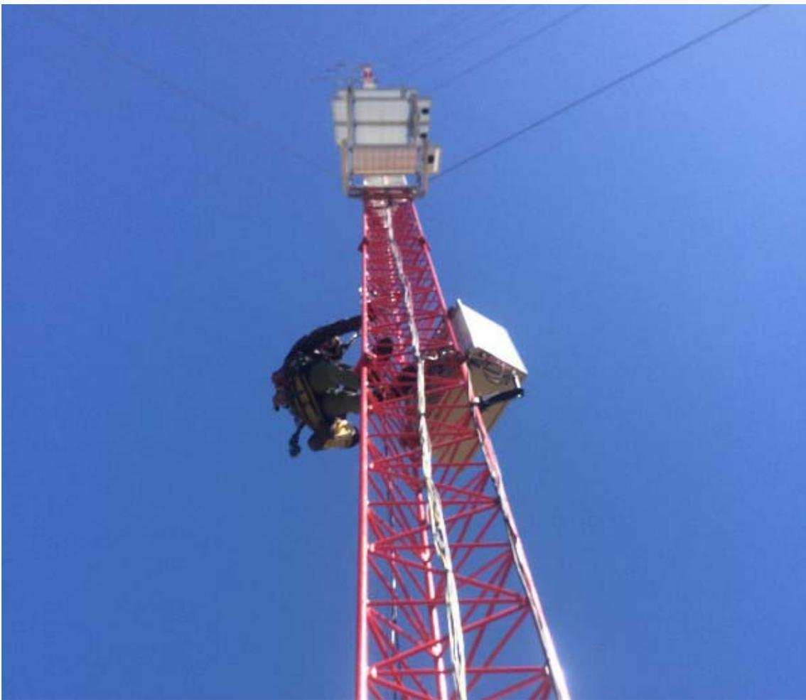
*En haut, le dispositif d'écoute : support micro et kit de fixation - En bas : l'intervention d'un grimpeur de ENCIS WIND pour la pose du matériel*
